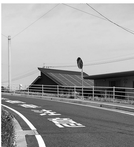
カーブミラー設置後
