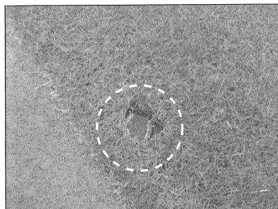
地中に埋められた散水用スプリンクラー
